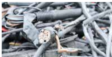
Faisceaux de câbles
